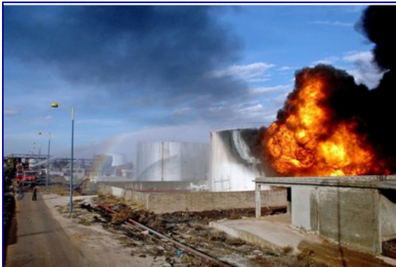
Réservoir en feu en novembre en Syrie, dans une raffinerie de la province de Homs. Source : EPA.
